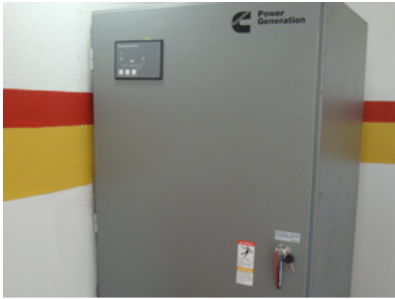
Painel de comando responsável pela transferência entre concessionária de energia e Grupo Gerador.
