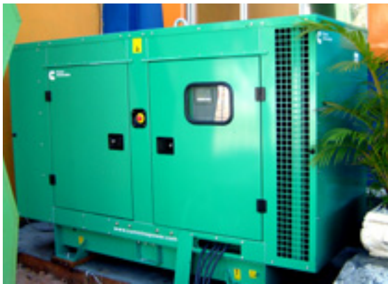
Acima, o Grupo Gerador modelo C90 D6 Carenado, que garante energia contínua em casos de emergências, sem que os ruídos atrapalhem a diversão.
