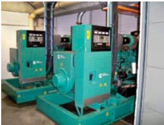
Na imagem à esquerda, é possível observar os Grupos Geradores Cummins modelo C400 D6. Na seqüência, o painel DMC1000.
