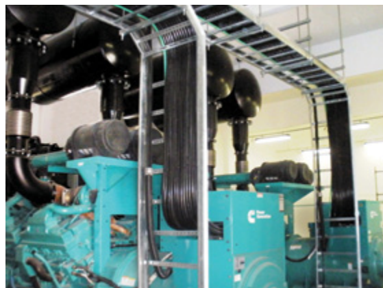
Na imagem à esquerda, é possível observar um dos Grupos Geradores Cummins modelo C2000 D6. Na sequência, detalhes da instalação.
