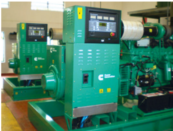
À esquerda, os 2 Grupos Geradores Cummins Power Generation modelo C400 D6 com destaque para o controle PowerCommand™ PCC 3100. À direita, em primeiro plano, o Grupo Gerador e, ao fundo, o painel de paralelismo com o controle DMC1000.
