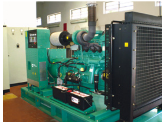
À esquerda, os 2 Grupos Geradores Cummins Power Generation modelo C400 D6 com destaque para o controle PowerCommand™ PCC 3100. À direita, em primeiro plano, o Grupo Gerador e, ao fundo, o painel de paralelismo com o controle DMC1000.
