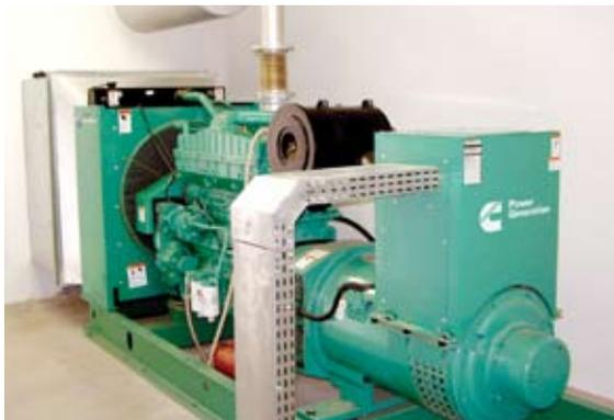
Grupo Gerador instalado em sala apropriada, com kit de atenuação de ruído.
