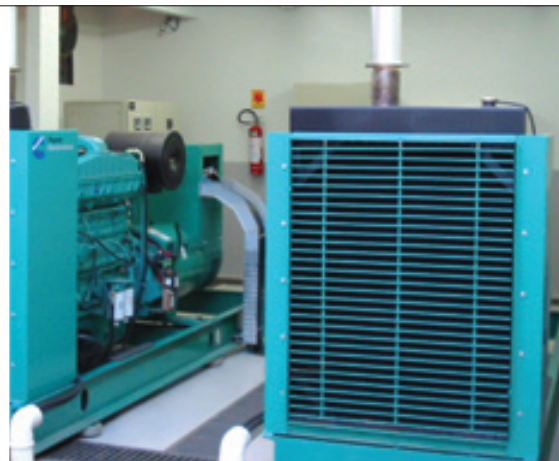
Acima, os Grupos Geradores Cummins Power Generation já devidamente instalados.
