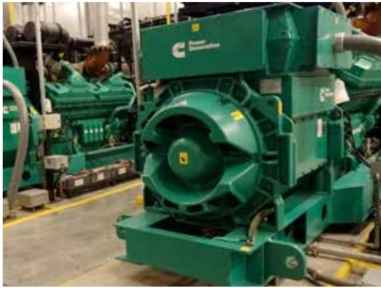
Adaptação do local para a instalação do Grupo Gerador
